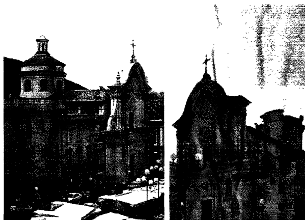
La Chiesa di Santa Maria del Suffragio all'Aquila prima e dopo il sisma
