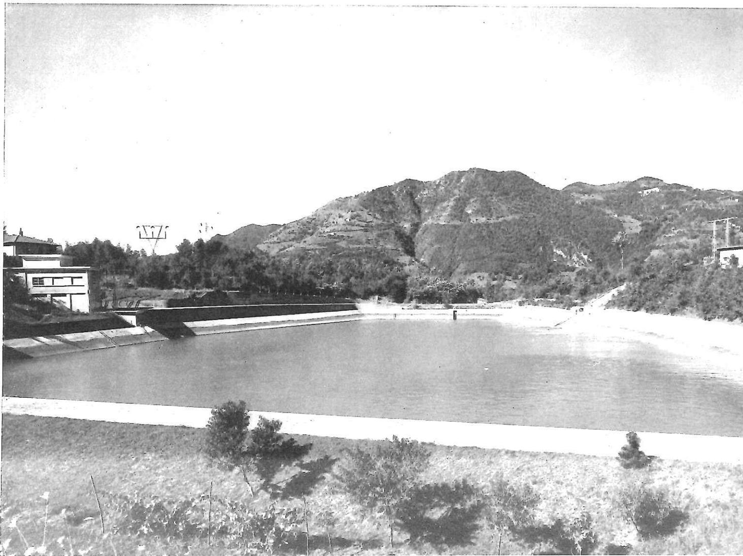
**L'IMPIANTO DI COVOLI** funzionante sin dal 1899, è stato completamente rinnovato nel 1949. Utilizza le acque del torrente Toscolano. La potenza efficiente dell'impianto è di kW 1.300 e la producibilità annua di 9 milioni di kWh.
