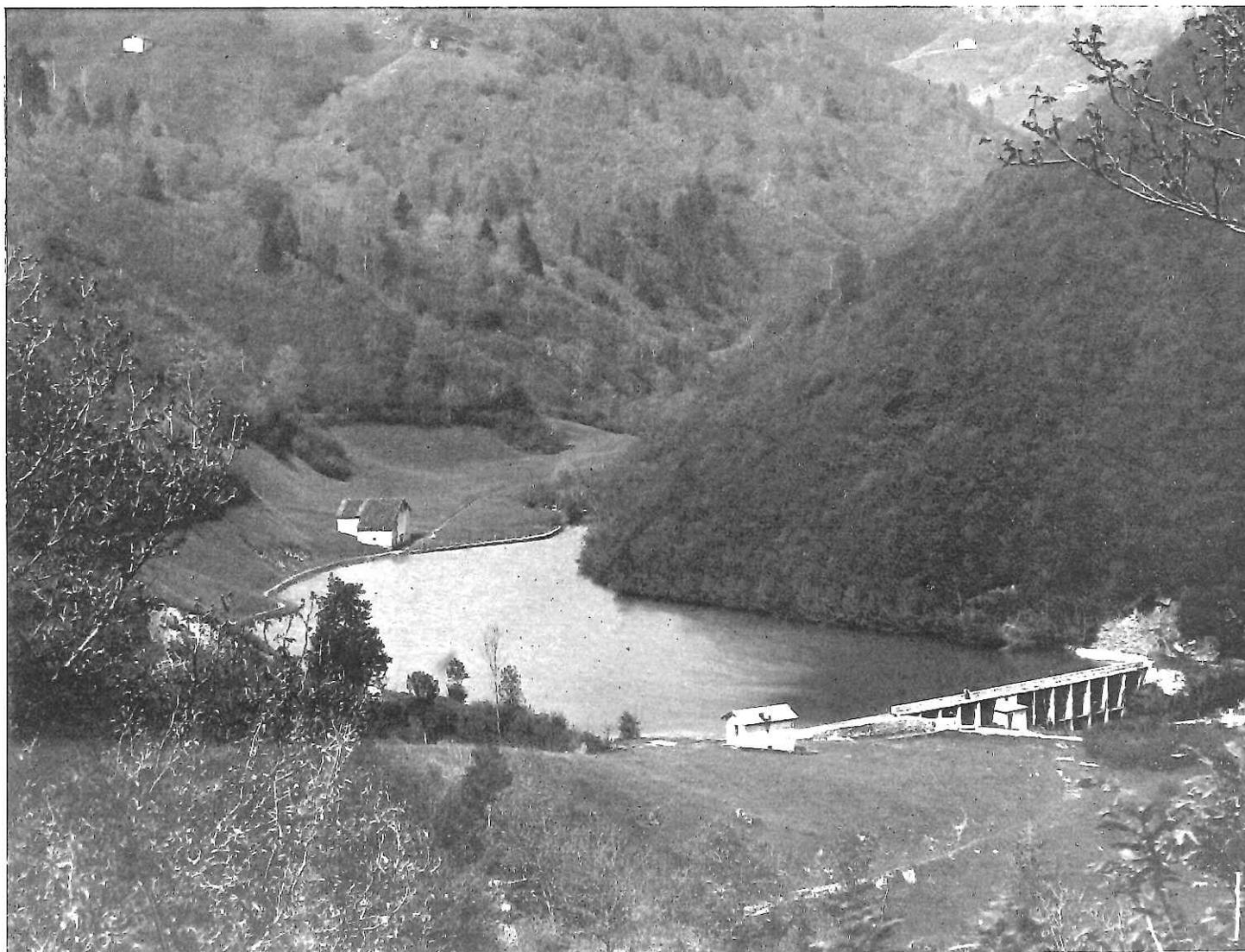
La piccola **CENTRALE DI LIVEMMO** nella quale è installato un gruppo Pelton-alternatore di 210 kVA, utilizza le acque del Tovere, affluente del Nozza, a sua volta affluente del Chiese. La producibilità annua è di circa 800.000 kWh.
