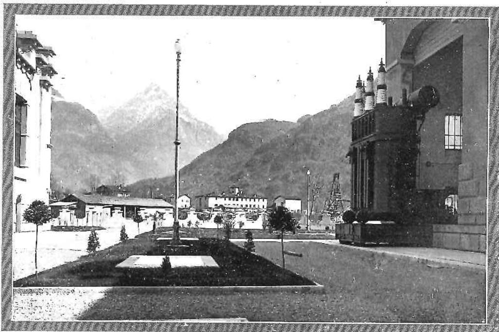
Centrale di Mese - Trasformatore da 30.000 kVA : 8000/140.000 Volta pronto per la messa in opera. — Fig. 17.
