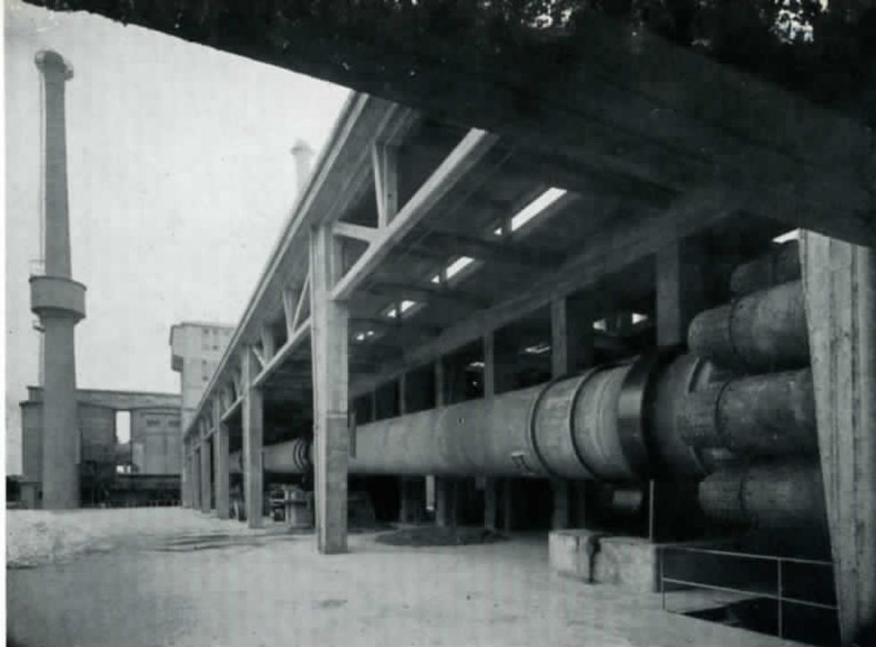
FORNO ROTATIVO DI UN CEMENTIFICIO.
