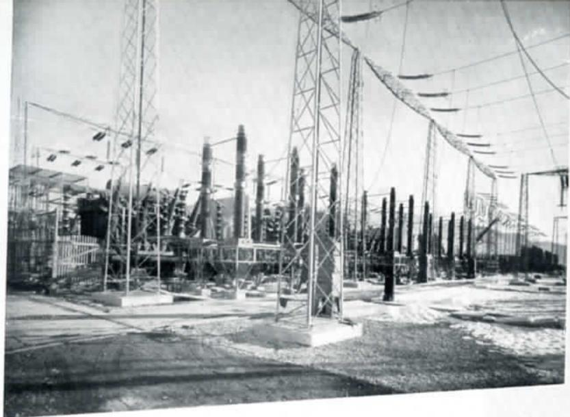
La stazione di trasformazione e di smistamento di Taio punto di arrivo (oltre a varie linee a 130 kV) della linea a 220 kV proveniente da Santa Massenza e punto di partenza della linea a 220 kV che attraverso il Passo del Tonale e la Val Camonica raggiunge Milano.
