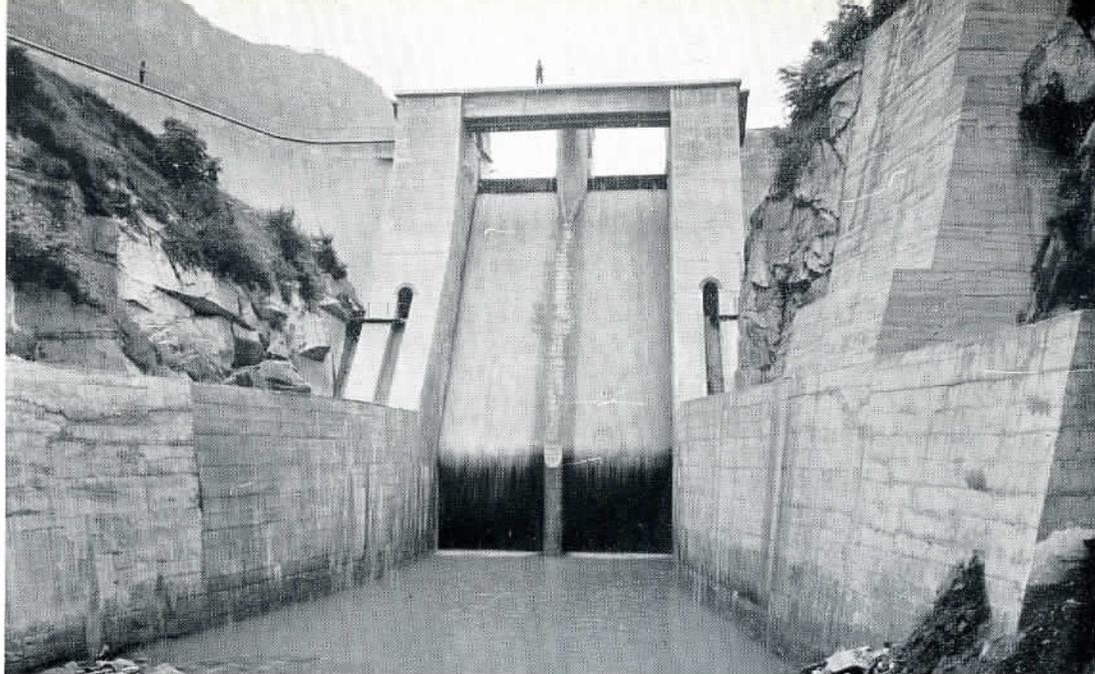
Il corpo centrale cavo della diga di Villa di Chiavenna. Il serbatoio alimenta la centrale di Chiavenna che ha una potenza installata di 60 000 kW ed una produttività annua di 202 milioni di kWh.
