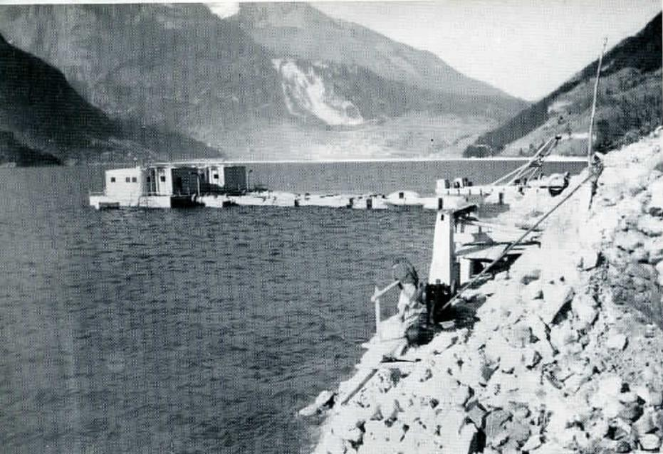
Il lago di Molveno prima dello svuotamento. Sono visibili le due stazioni galleggianti di elettropompe. Lo svuotamento è stato necessario per la costruzione delle opere di presa sul fondo del lago.
