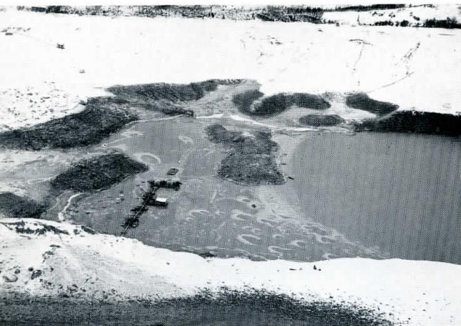
Il serbatoio del lago di Molveno a svuotamento completato (gennaio 1953). Il serbatoio (capacità utile 234 milioni di metri cubi d'acqua) allimenterà la centrale di Santa Massenza che è la più importante del sistema di impianti a Nord del lago di Garda. La Società Edison partecipa direttamente alla « Società Idroelettrica Sarca-Molveno » alla quale tali impianti appartengono.
