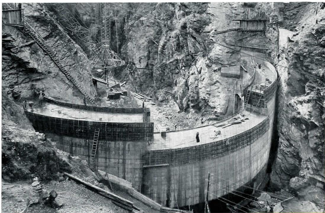
La diga del Sabbione. - Nell'alto bacino del Toce, a 2460 m. sul livello del mare, si sta costruendo l'impianto del Sabbione-Morasco, che comporta la creazione di un serbatoio stagionale alle falde del ghiacciaio omonimo. Le acque regolate dal serbatoio saranno utilizzate nella centrale in caverna di Morasco dotata di due gruppi generatori per complessivi 52 000 kW.
