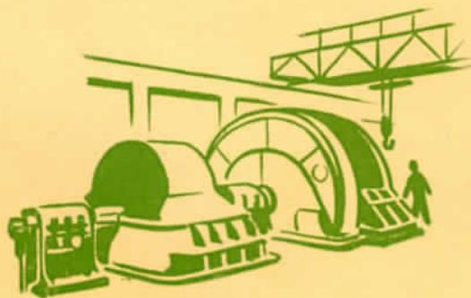
Veduta parziale della sala macchine in caverna della centrale di Santa Massenza I, con in primo piano un gruppo da 70000 KVA e relativo trasformatore.
