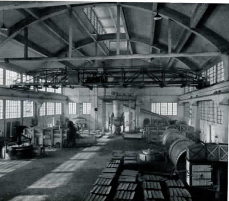
Nello stabilimento è stata estesa la meccanizzazione delle lavorazioni, particolarmente nei processi di colata e di rifinitura delle griglie e in quelli di applicazione della pasta di ossidi di piombo alle griglie stesse.
