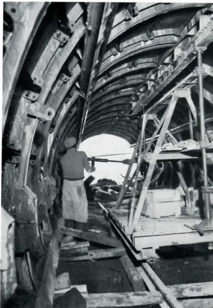
Costruzione della centrale in pozzo di Vinadio dell'impianto Stura di Demonte. In primo piano le fondazioni del macchinario.
