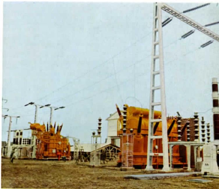
Nella stazione di Milano-Lambrate, dove sono installati un primo trasformatore da 70 000 kVA ed un compensatore sincrono da 50 000 kVA, avviene il passaggio dall'aereo in cavo sotterraneo della linea a 220 kV proveniente dal Trentino e dalla Val Camonica.
