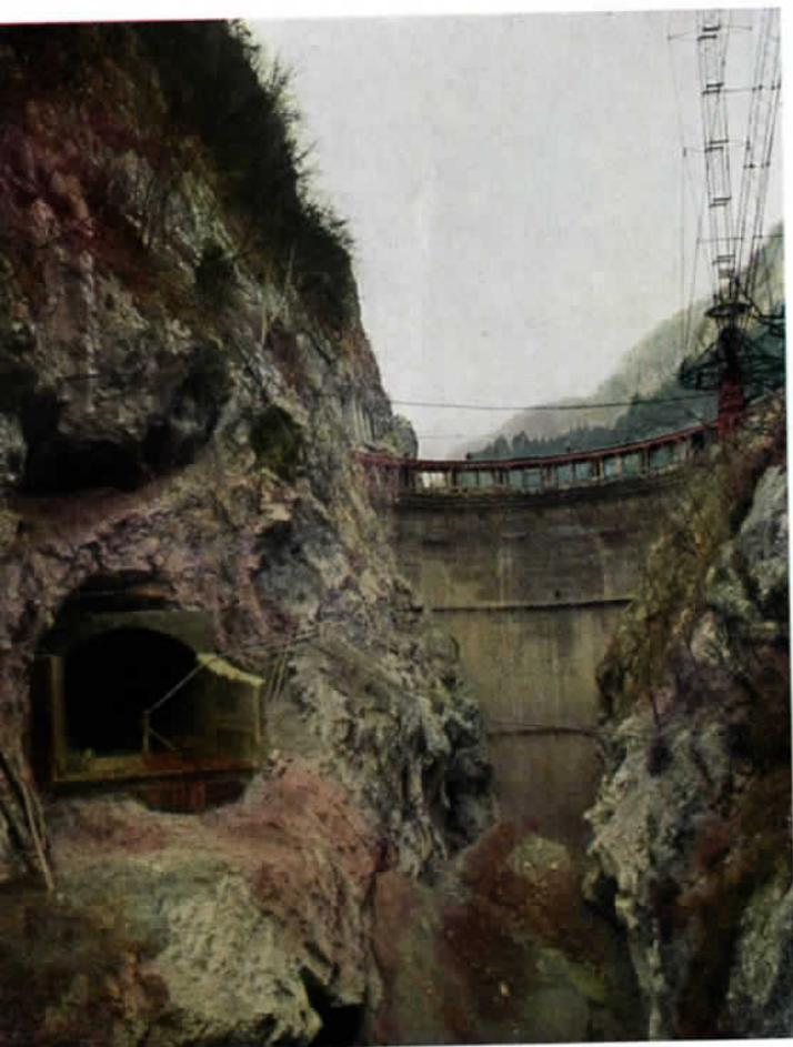
La diga di Ponte Pià in avanzata fase di costruzione. Il serbatoio di Ponte Pià fa parte dell'impianto di S. Massenza II° in corso di realizzazione da parte della Società Idroelettrica Sarca Molveno (alla quale il Gruppo Edison partecipa alla pari con il Gruppo S.I.P.). La diga è del tipo a volta a doppia curvatura, ha un'altezza massima di 54 m, uno sviluppo al coronamento di 58 m, esclusi i muri di spalla, ed un volume di circa 8 000 m<sup>3</sup>.
