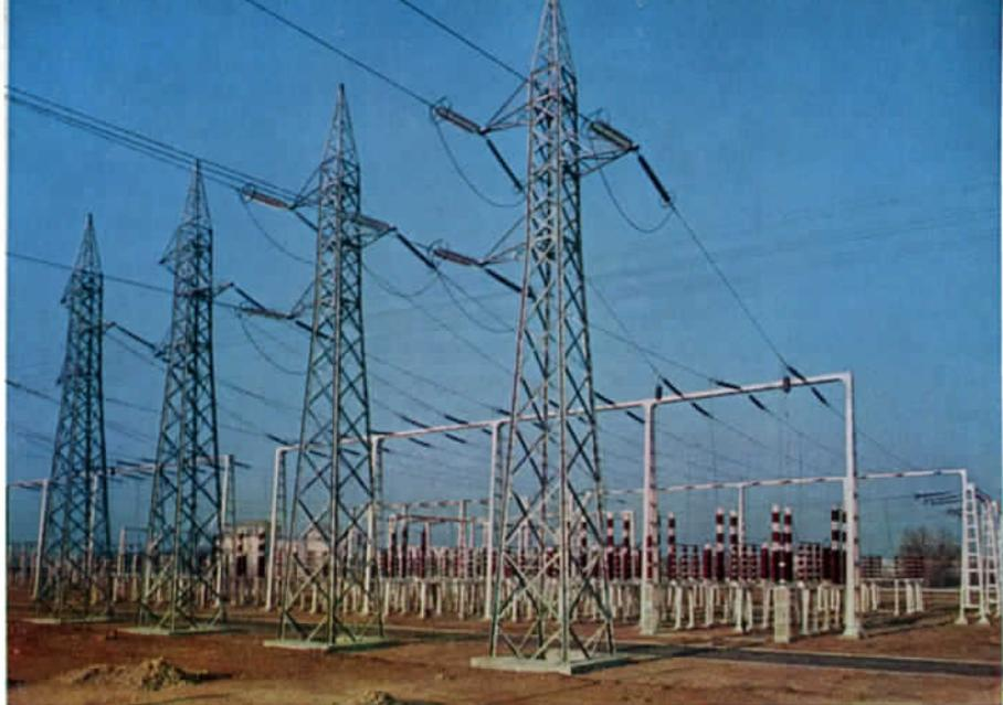
Veduta della parte all'aperto della nuova stazione di trasformazione a 130 kV di Coccaglio della Società Elettrica Bresciana. In essa sono installati due trasformatori per una potenza complessiva di 26 mila kVA.
