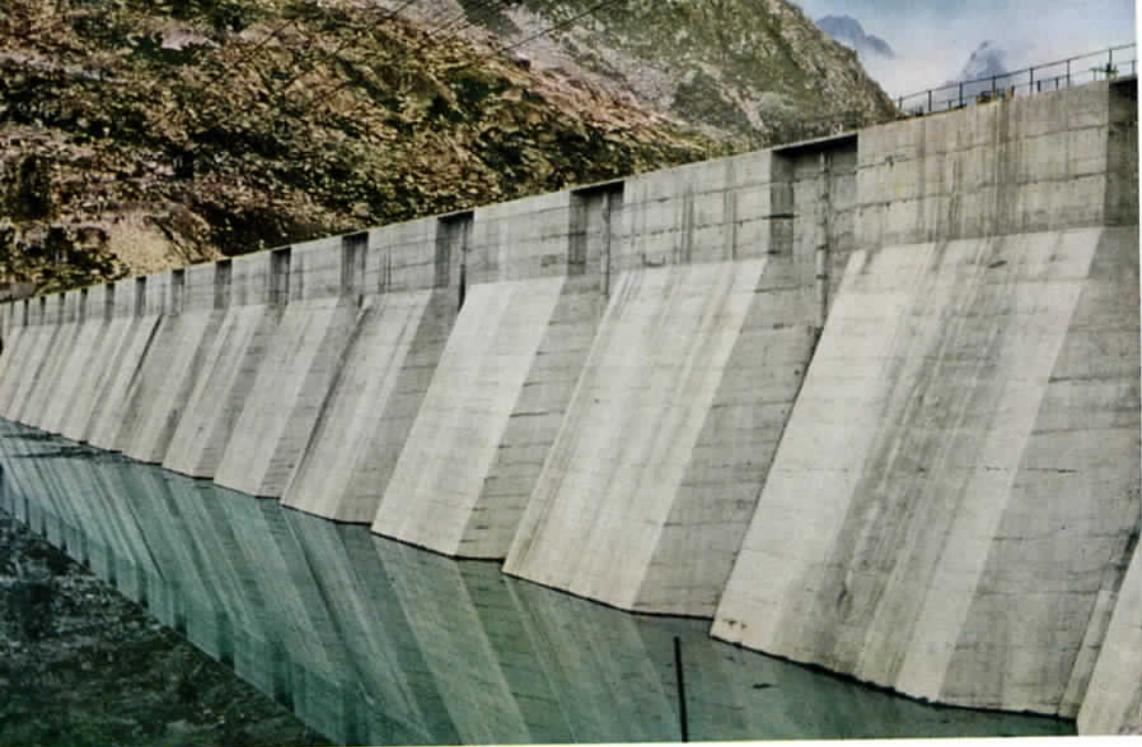
La «Soc. Anonima Lavori e Costruzioni - SALCI» specializzata nella costruzione di opere idrauliche ha ultimato nel corso del 1956 la diga del Pantano d'Avio, della Edisonvolta S.p.A., nell'alta Val Camonica. La diga, del tipo a gravità alleggerita, a tracciato rettilineo, è costituita da 15 elementi cavi indipendenti e da due tronchi di estremità massicci; l'altezza sul punto più depresso delle fondazioni è di 65 m, lo sviluppo al coronamento di 400 m,
