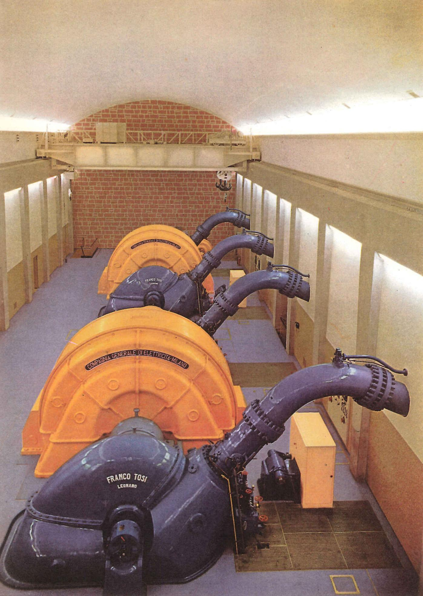
La sala macchine della centrale in caverna di Boazzo nel bacino superiore del fiume Chiese coi due gruppi principali d'una potenza complessiva di 94 740 kW.
