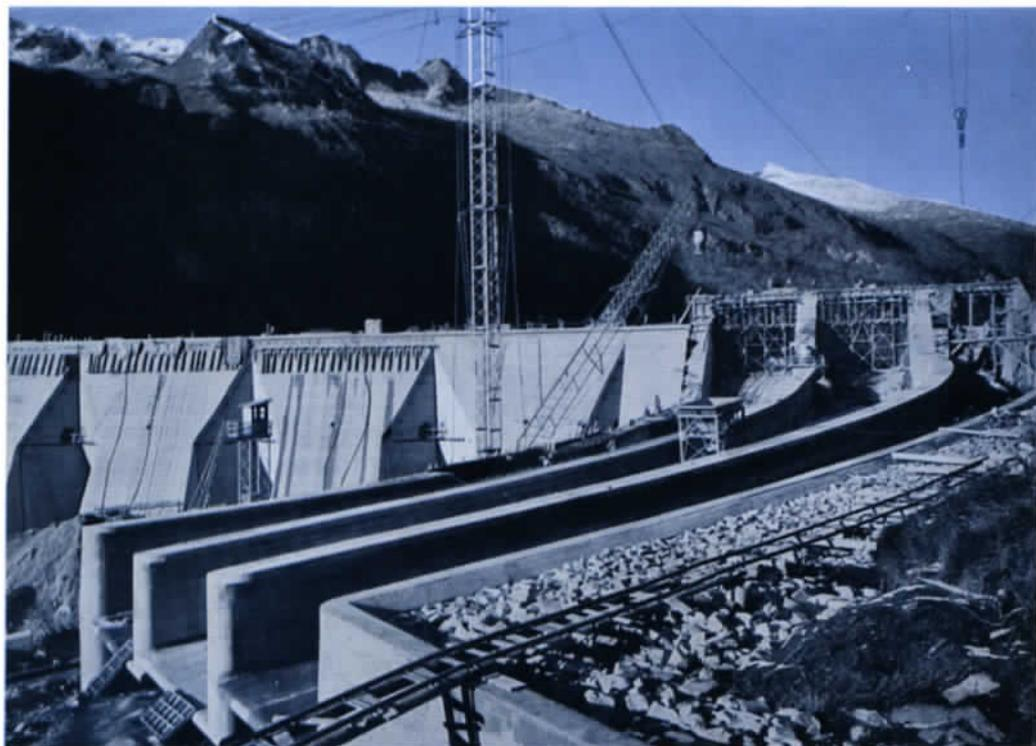
Il serbatoio ha una capacità utile di 60 milioni di mc. con quota di massimo invaso a 1 788 metri s.l.m. Nella fotografia lo scarico di superficie, in sponda sinistra della diga.
