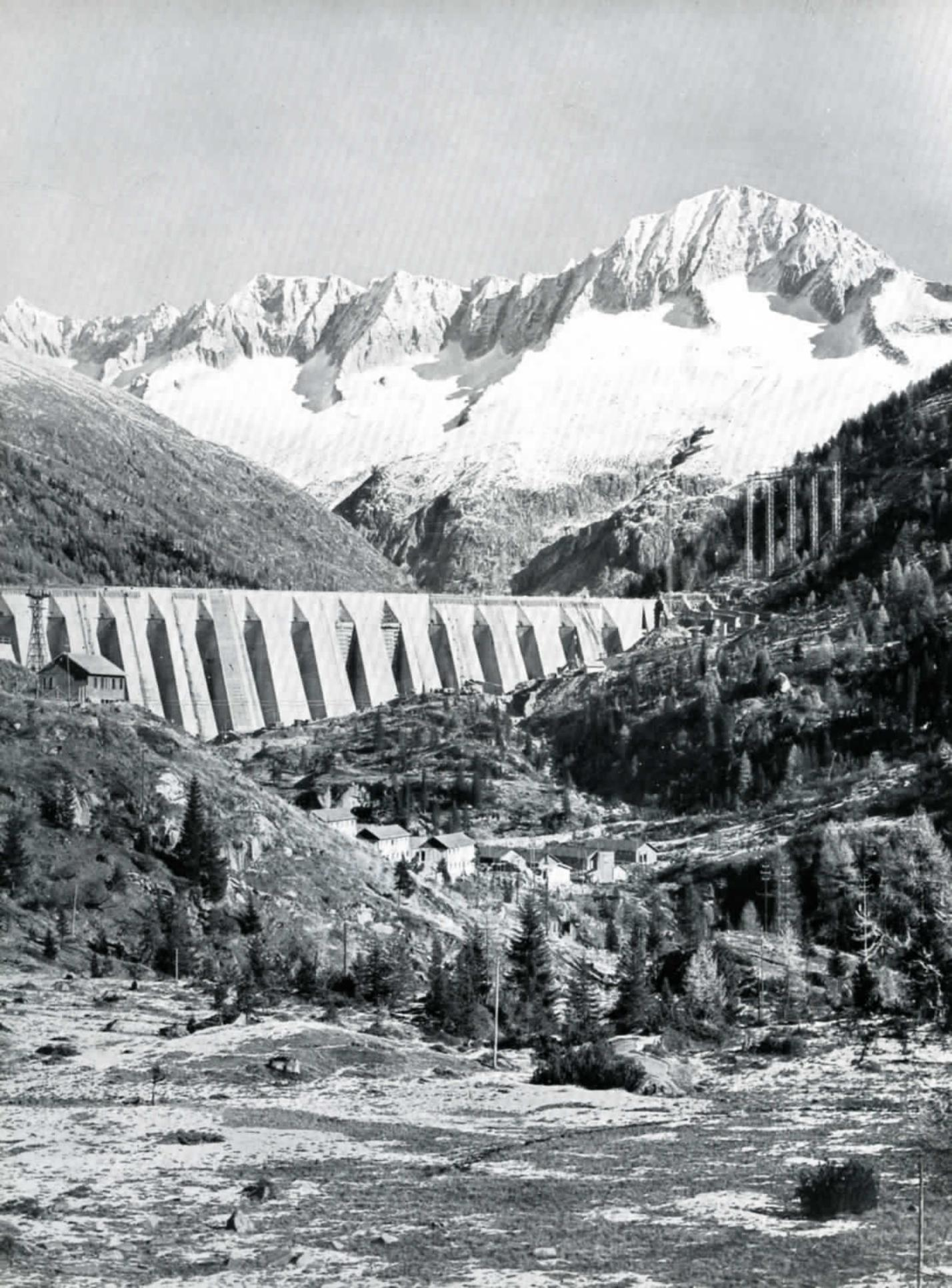
La diga di Malga Bissina, del tipo a gravità alleggerita, ha una lunghezza complessiva al coronamento di 561 m., un'altezza massima di 87 m. ed un volume di circa 440 000 mc.
