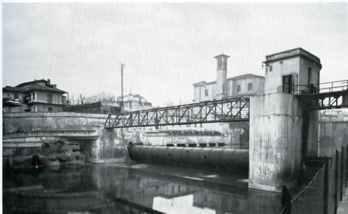
Impianto di Bonate Paratoia cilindrica di presa
