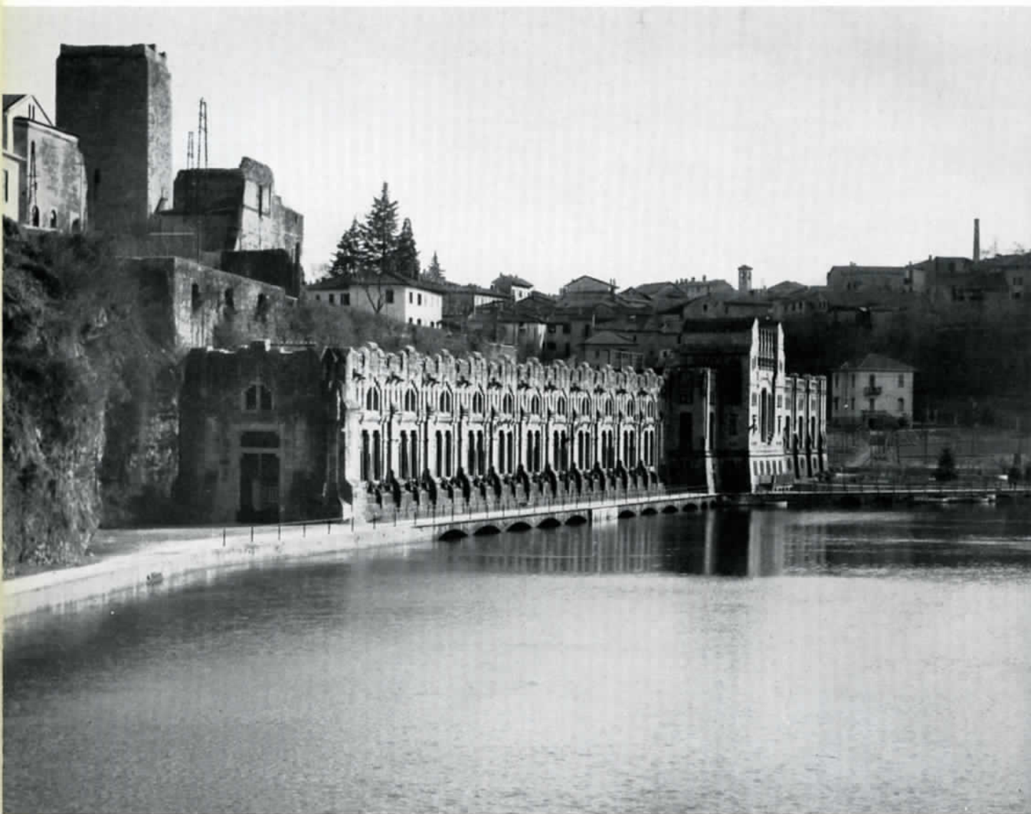
Trezzo sull'Adda Centrale Taccani e bacino di carico
