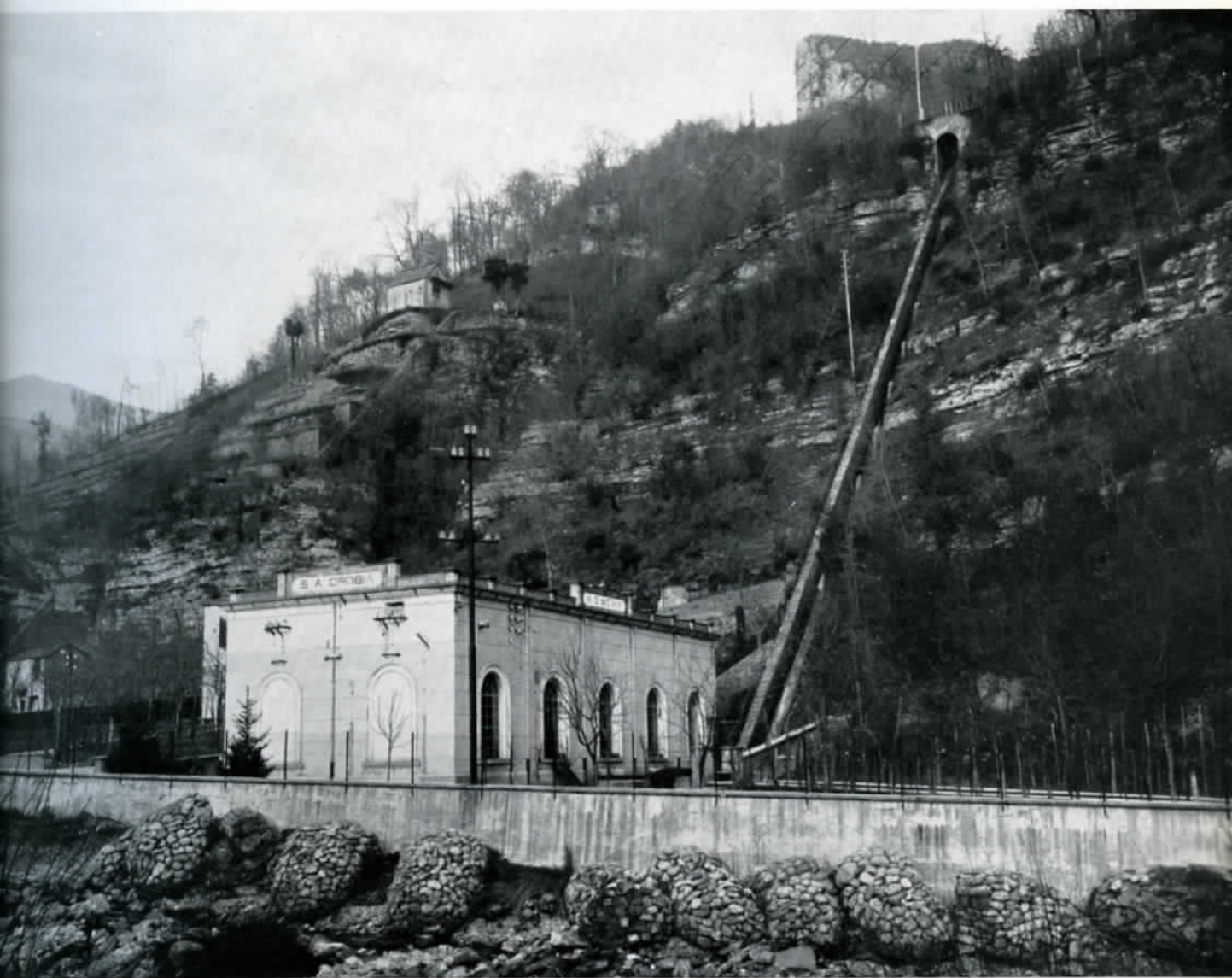
Centrale di Locatello
