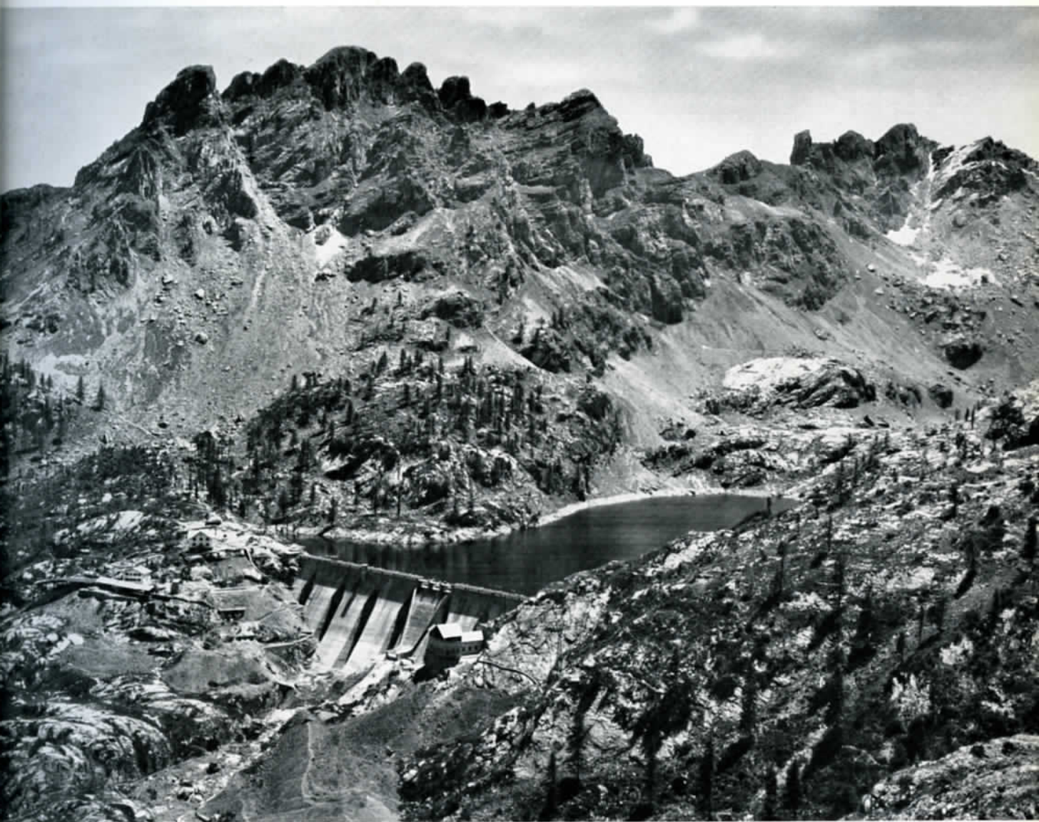
Diga e serbatoio di Trona
