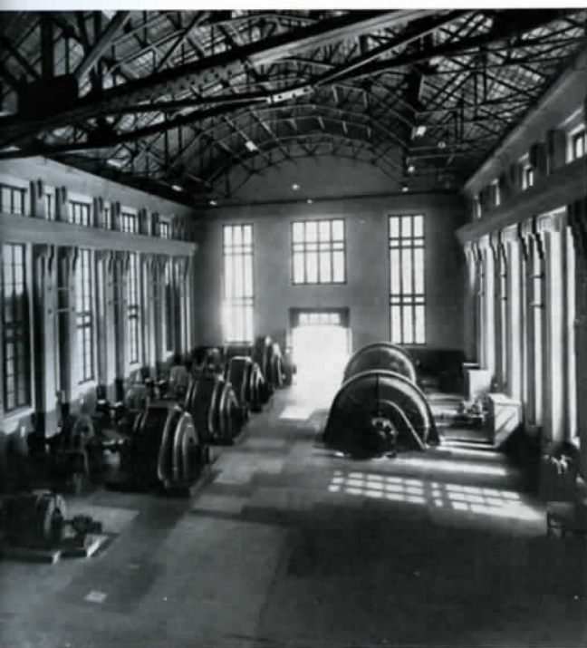
Serbatoi del Piano Barbellino e di Val Morta Centrale Dossi - Sala macchine
